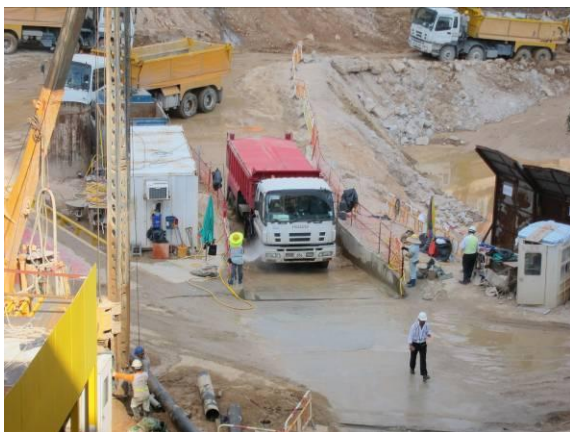
地盤工人在車輛離開時向車胎灑水，而「泥頭車」亦必須經過水池
