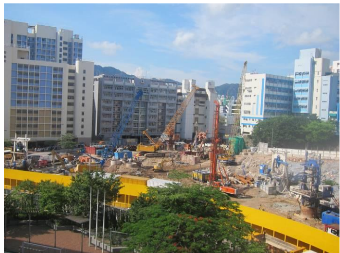
現時地盤施工時的情況。
